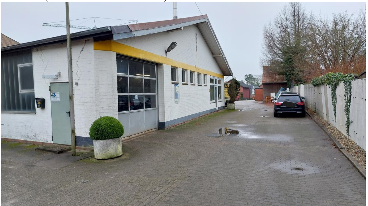
Foto 4: Blick nach SSE, Kfz-Halle (KVF04), davor ehem. Tankstelle (KVF03) (Aufnahmedatum: 09.01.2025)
