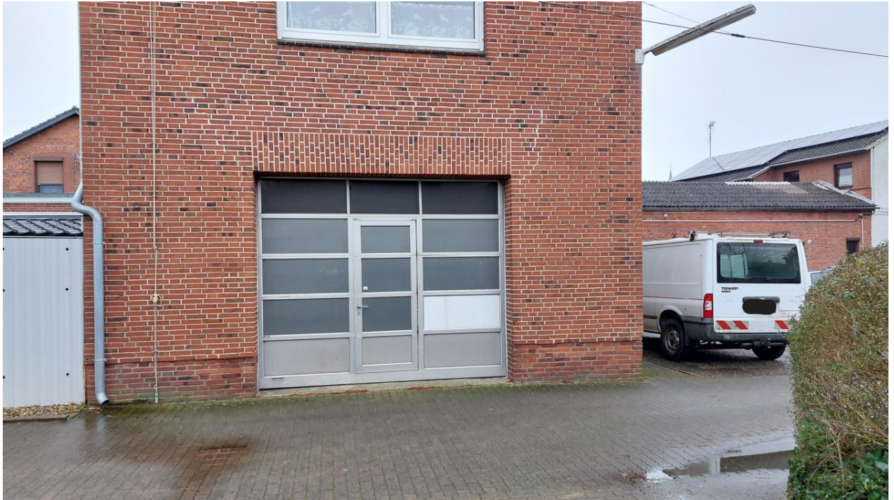
Foto 3: Blick nach W, Einfahrt ehem. Kfz-Waschhalle (KVF01) (Aufnahmedatum: 09.01.2025)
