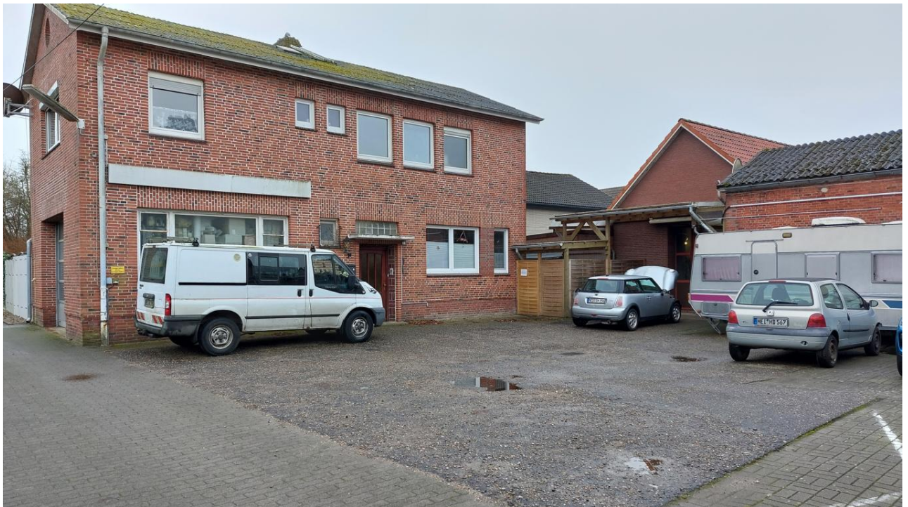
Foto 2: Blick nach SW, Blick auf ehem. Kfz-Waschhalle (KVF01) (Aufnahmedatum: 09.01.2025)
